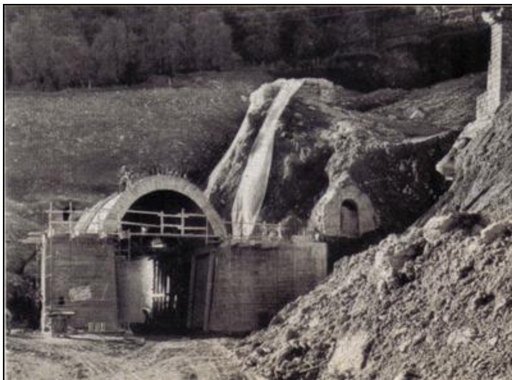
Reconstruction du fronton du tunnel de Gigne A sa droite l'ancienne entrée des chambres de destruction de l'ouvrage Et à l'extrême droite, un pan de mur du fronton du tunnel de Carança
