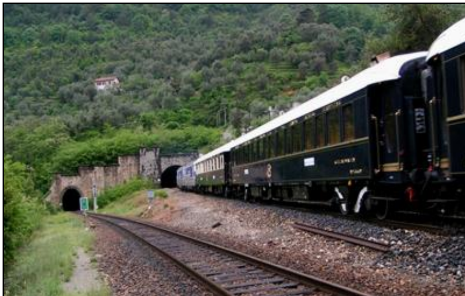
L'entrée du tunnel de Gigne à gauche pendant qu'un train s'engouffre dans le tunnel de Carança à droite
