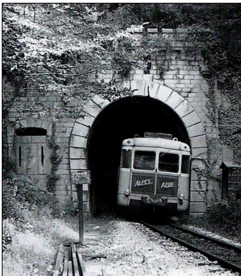
Ci-dessus, l'entrée du tunnel hier...
