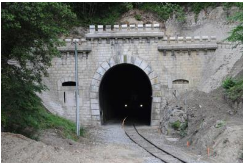
L'entrée dans son état actuel après réfection
