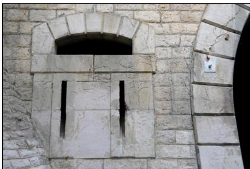
Ci-dessus, gros plan sur les meurtrières de façade du corps de garde
