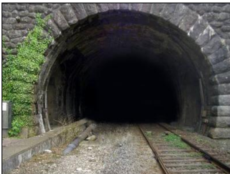
La belle sortie du tunnel, dans un appareillage particulièrement massif
