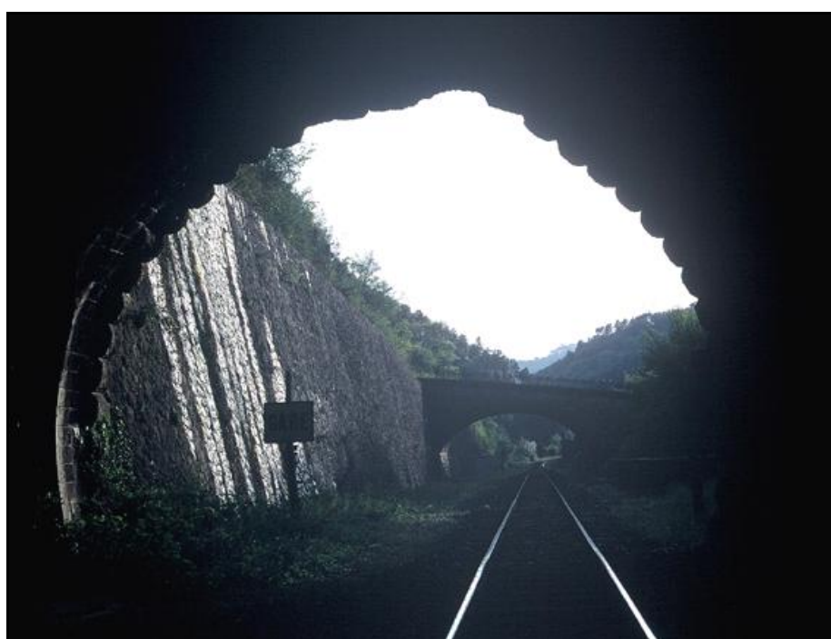
Ci-dessus et ci-dessous, trois photos de l'entrée du tunnel de Braus
