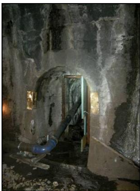
Le débouché du captage principal dans la galerie
