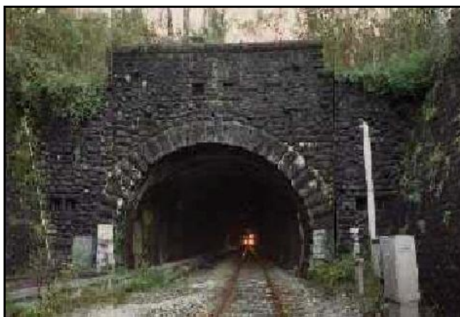
Au fond du tunnel, phares d'un train en approche
