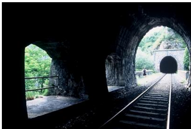
L'entrée du tunnel vue depuis la sortie du tunnel de Mezzora
