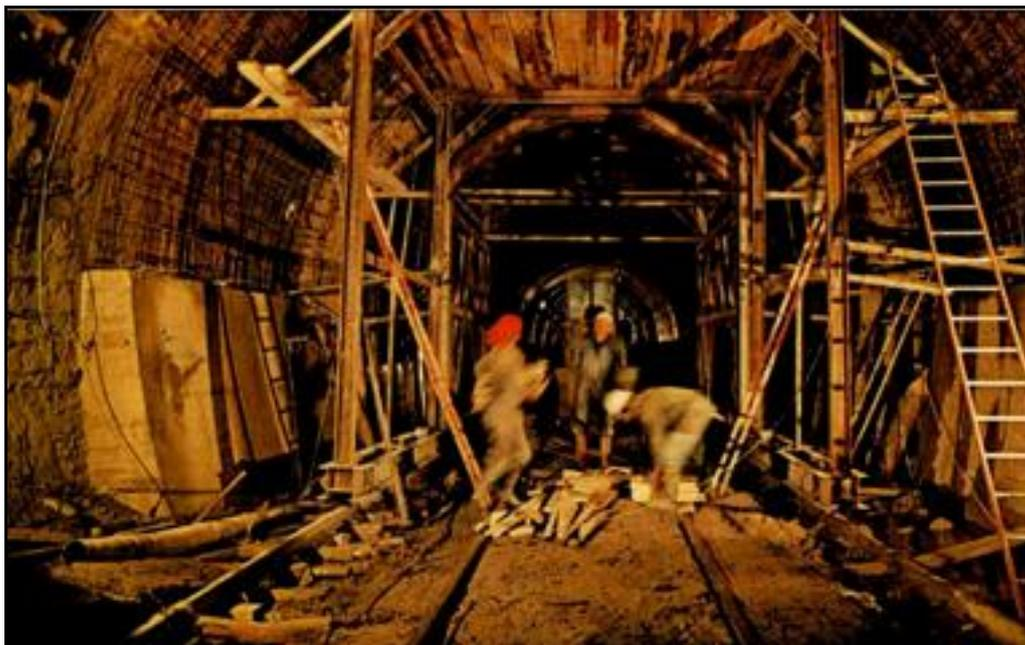
Ci-dessus et ci-dessous, deux photos des travaux de rénovation du tunnel, reprise des parements et de l'étanchéité de la voûte et des piédroits, et construction de deux drains latéraux pour écouler les eaux d'infiltration très abondantes
