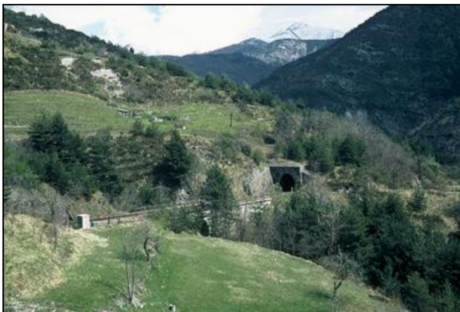
Autre vue de la sortie du tunnel dans son cadre alpestre
