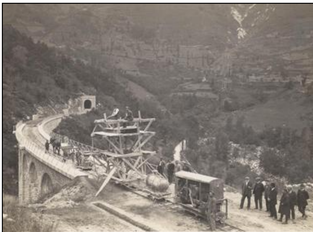
Une belle photo de l'entrée du tunnel de Runac lors de sa construction
