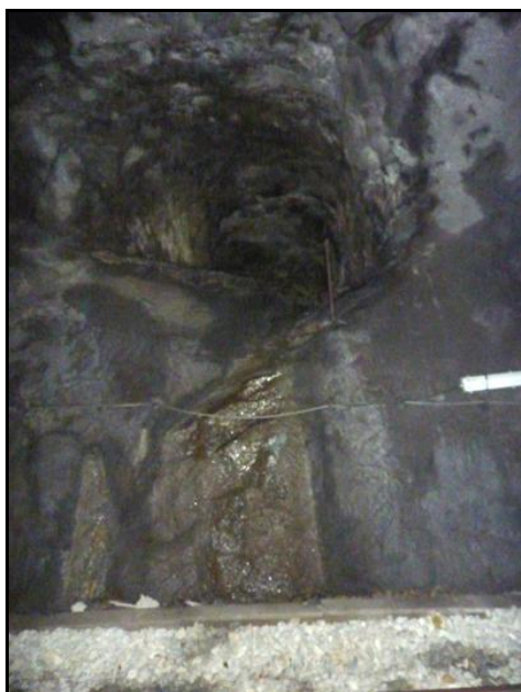
Dans la paroi droite, le trou qui communique avec l'extérieur
