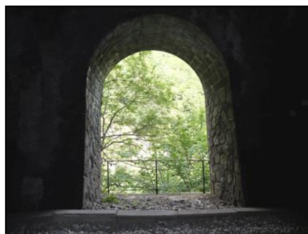
Ci-dessus et ci-dessous, la galerie de protection construite à la place de l'ancienne sortie du tunnel de Runac
