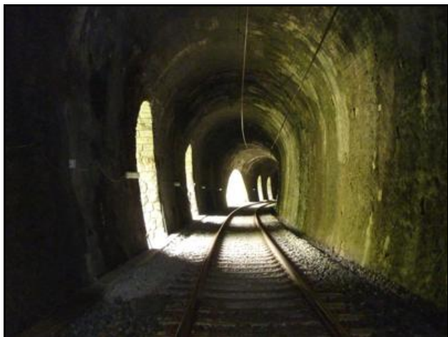
La galerie de protection et l'une de ses fenêtres qui donne sur l'ancienne plateforme ferroviaire abandonnée entre les tunnels de Runac et Berduquet
