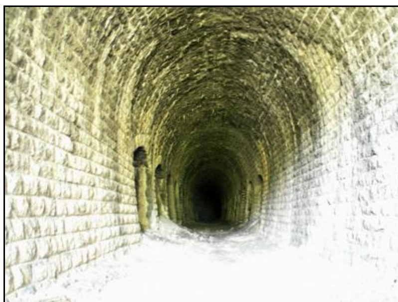
Ci-dessus et ci-dessous, la galerie du tunnel
