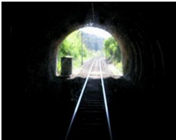
Intérieur du tunnel côté sortie Photo non datée
