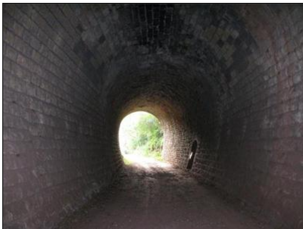
La sortie vue depuis l'intérieur de la galerie
