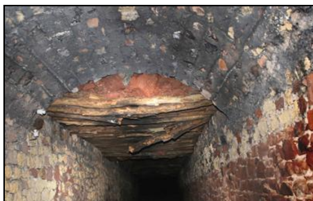
Ci-dessus et ci-dessous, premier platelage de protection avec bois brisés et coulées de pierres
