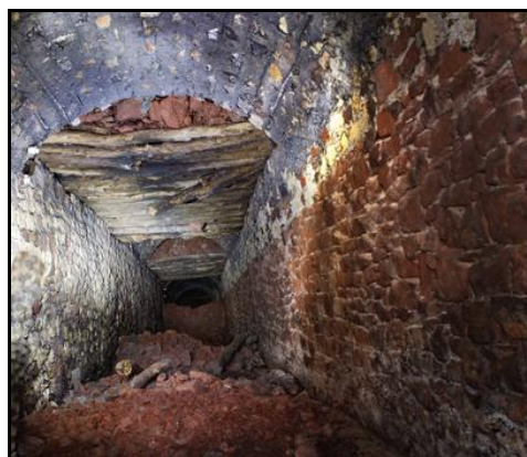
Ci-dessus et ci-dessous, premier platelage de protection avec bois brisés et coulées de pierres
