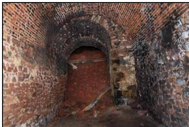
Ci-contre et ci-dessous, l'arrière du grand éboulis et le retour de la galerie au gabarit normal
