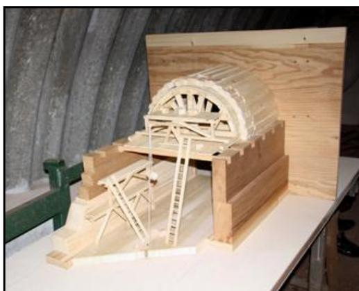
Maquette montrant le principe de construction de la voûte et le pourquoi des trous latéraux visibles au sommet des piédroits
