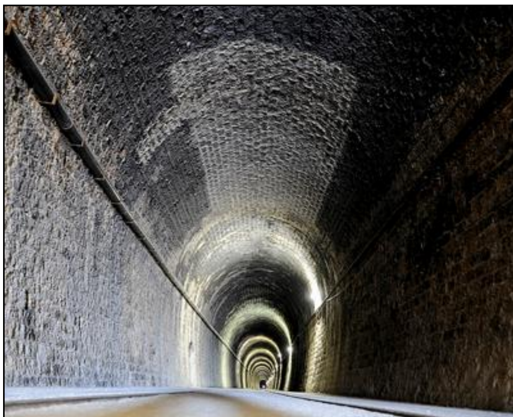
Ci-dessus et ci-dessous, deux vues de la galerie du tunnel
