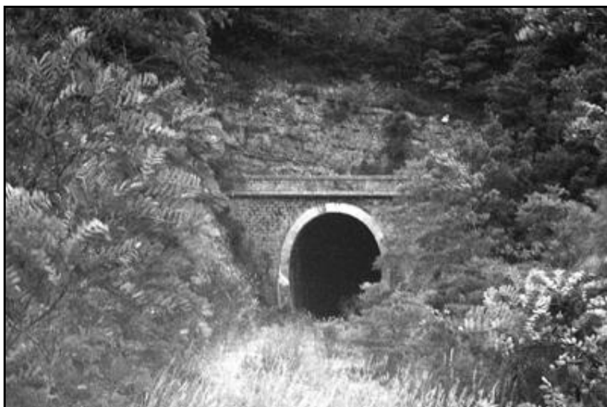
La sortie abandonnée du tunnel avant remise en service par l'armée
