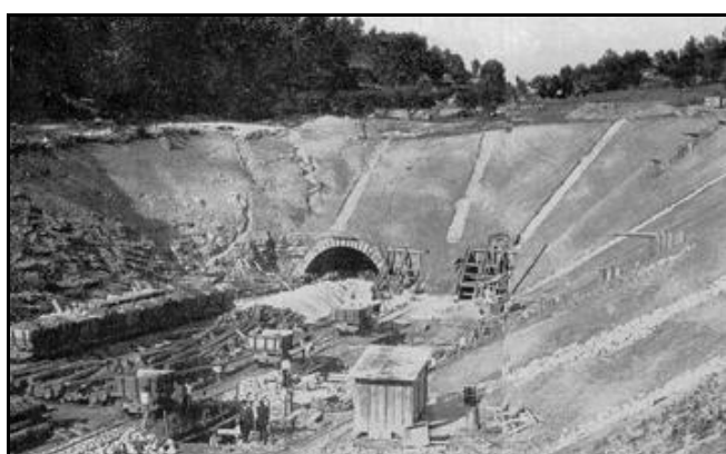
Ci-dessus et ci-dessous, travaux d'avancement du fronton d'entrée et de sa tranchée d'accès
