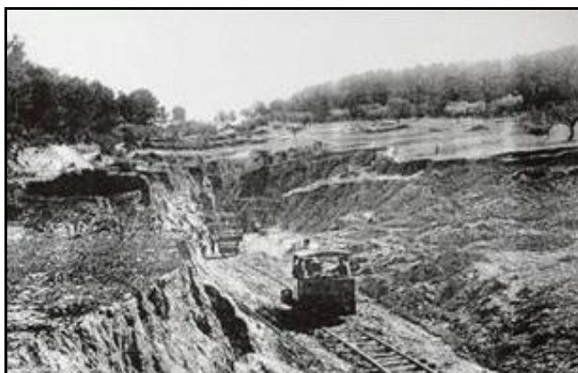
Début de creusement de la tranchée d'accès ouest au fond de laquelle sera établie l'entrée du tunnel
