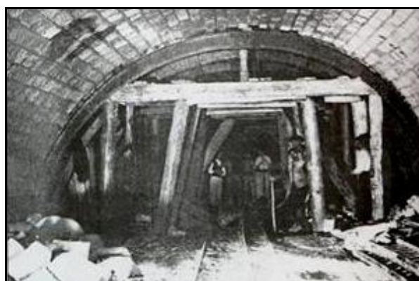
Deux clichés de la galerie en cours de réalisation Sur la photo de gauche, noter les bois de soutènement brisés par les poussées du terrain
