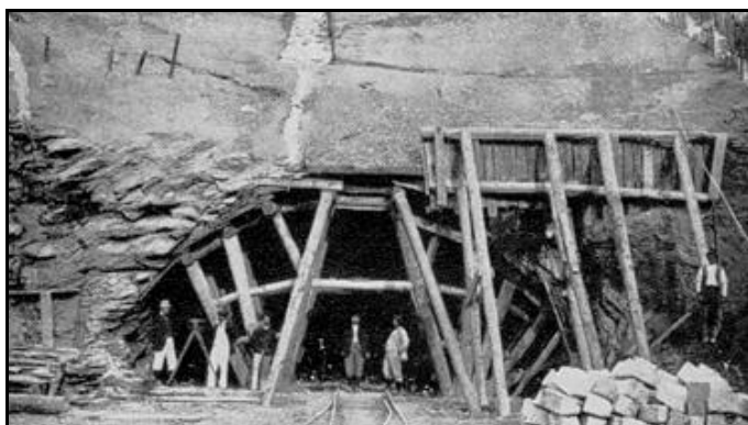
Ci-dessus et ci-dessous, les trois phases de creusement de la voûte, des abattages latéraux et de sa mise en sécurité par construction du parement dont on notera l'épaisseur en raison de la mauvaise qualité du terrain encaissant
