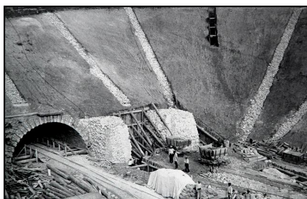
Ci-dessus et ci-dessous, travaux d'avancement du fronton d'entrée et de sa tranchée d'accès
