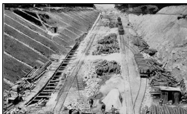
Ci-dessus et ci-dessous, la tranchée d'accès à l'entrée en cours de déblaiement et de construction
