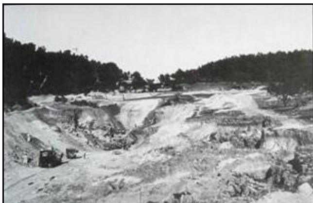
Début de creusement de la tranchée d'accès ouest au fond de laquelle sera établie l'entrée du tunnel
