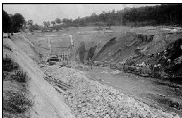
Ci-dessus et ci-dessous, travaux d'avancement du fronton d'entrée et de sa tranchée d'accès
