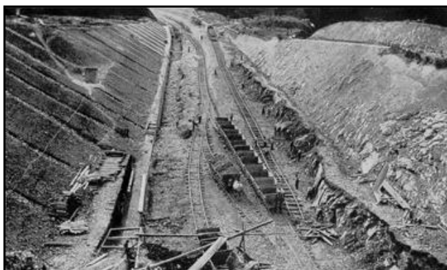
Ci-dessus et ci-dessous, la tranchée d'accès à l'entrée en cours de déblaiement et de construction
