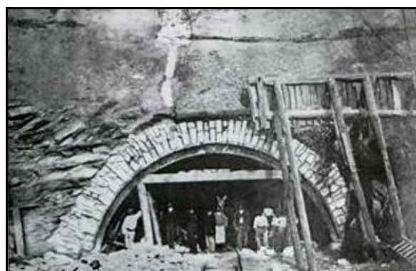
Ci-dessus et ci-dessous, les trois phases de creusement de la voûte, des abattages latéraux et de sa mise en sécurité par construction du parement dont on notera l'épaisseur en raison de la mauvaise qualité du terrain encaissant
