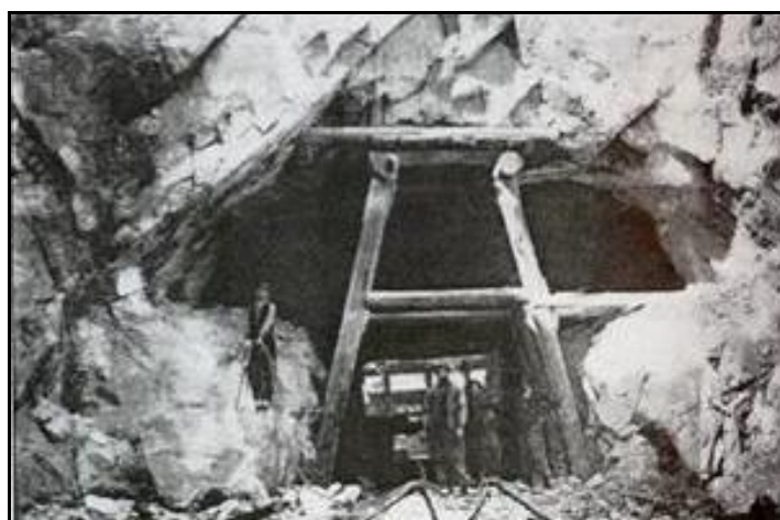
Enfin, une dernière photo de la sortie du tunnel, côté est vers Marseille
