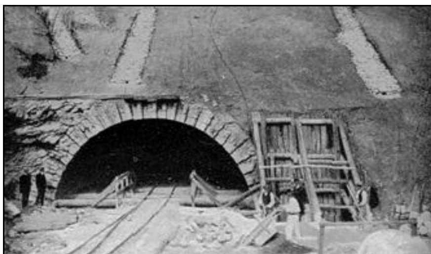
Ci-dessus et ci-dessous, les trois phases de creusement de la voûte, des abattages latéraux et de sa mise en sécurité par construction du parement dont on notera l'épaisseur en raison de la mauvaise qualité du terrain encaissant
