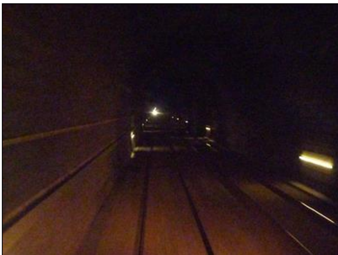
Dans la galerie du tunnel
