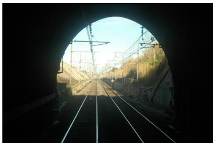
L'entrée vue de l'intérieur
