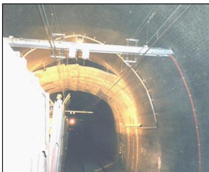
Ci-dessus et ci-dessous, photos de l'une des voûtes intermédiaires de renforcement
