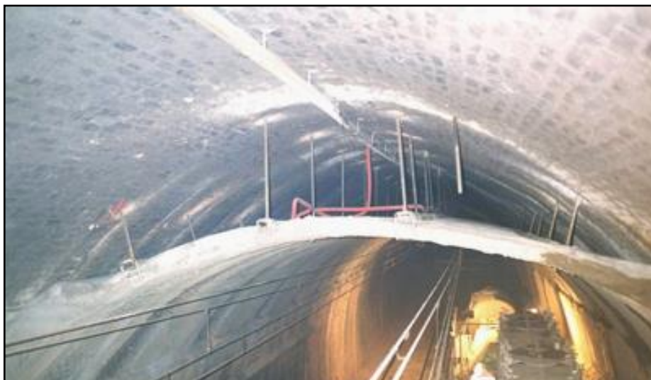
Ci-dessus et ci-dessous, photos de l'une des voûtes intermédiaires de renforcement
