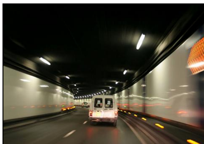
L'un des étages de circulation
