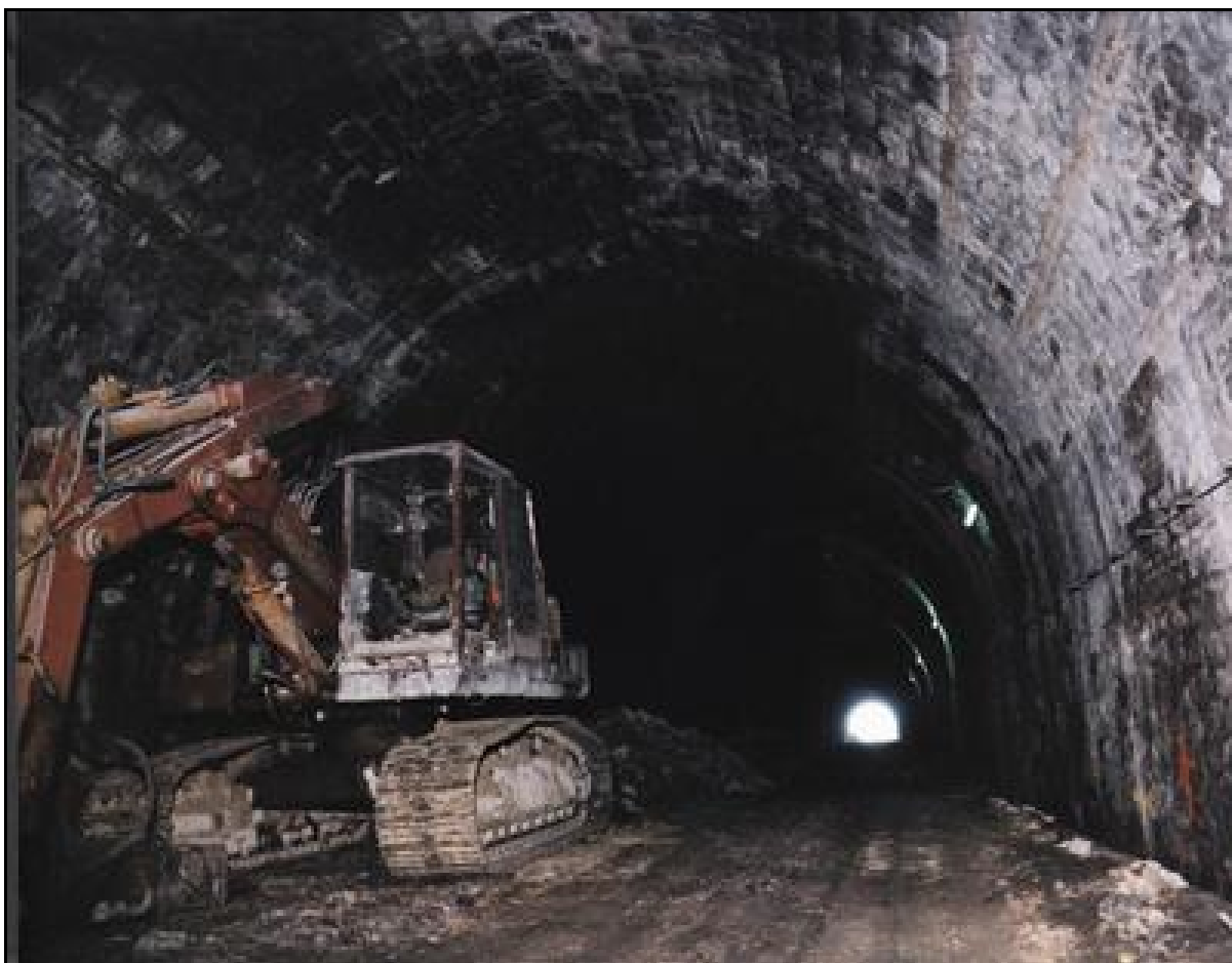
Début des travaux : nettoyage de l'ancien radier ferroviaire
