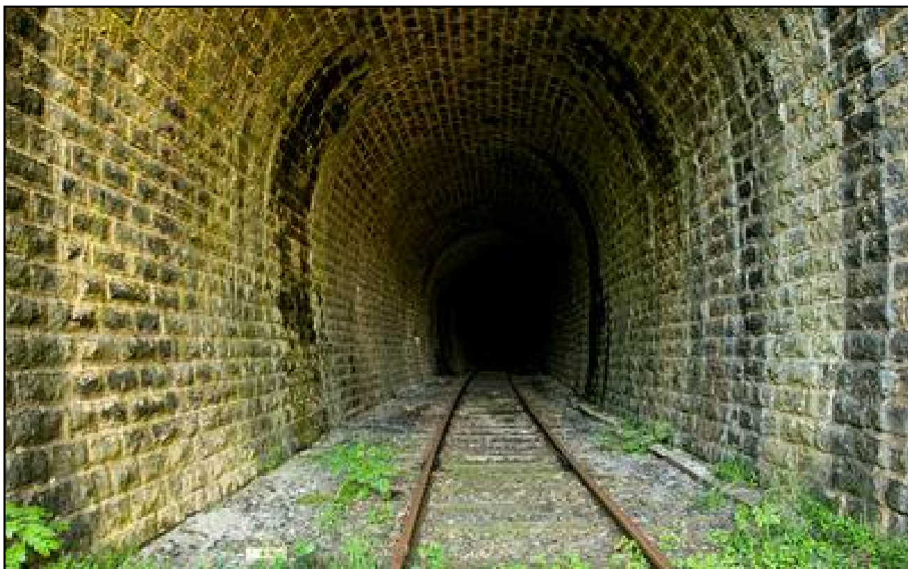
La galerie du tunnel
