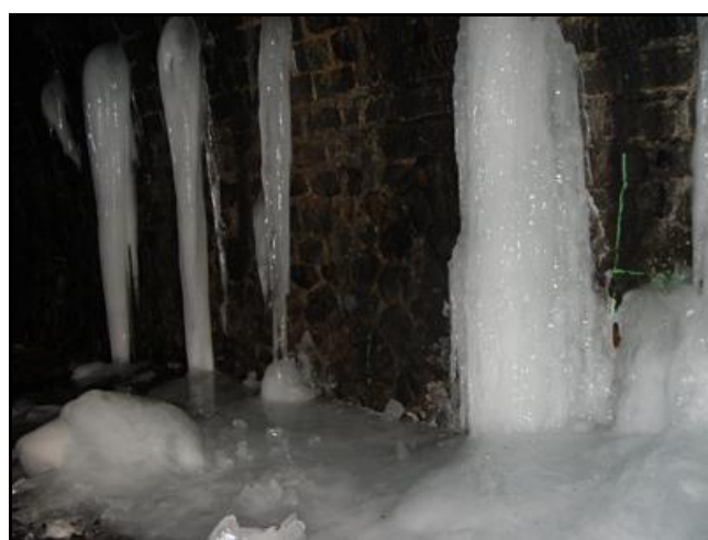
Ci-dessus et ci-dessous, effets spectaculaires des infiltrations et du gel hivernal
