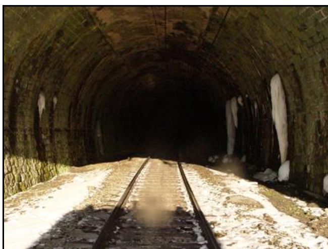
Ci-dessus et ci-dessous, effets spectaculaires des infiltrations et du gel hivernal
