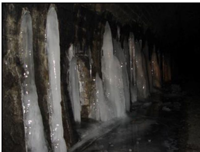
Ci-dessus et ci-dessous, effets spectaculaires des infiltrations et du gel hivernal
