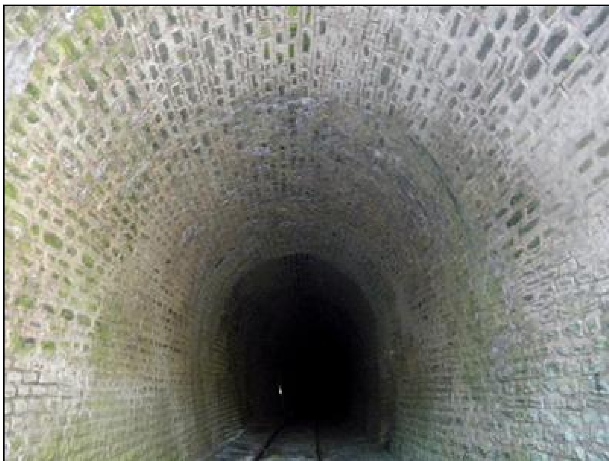
La belle voûte du tunnel du Verdier
