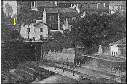
L'entrée nord du tunnel de la Gâtine du temps où il était encore en service sur le réseau de l'Etat. La flèche jaune indique l'entrée superposée du petit tunnel pour voie métrique de Grand Font
