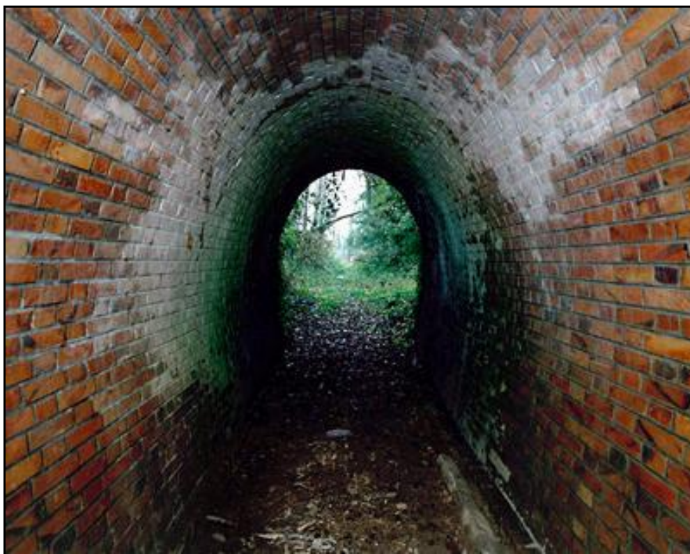
La jolie galerie parfaitement conservée du tunnel
