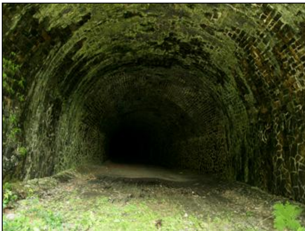
Ci-dessus et ci-dessous, la galerie en bon état
