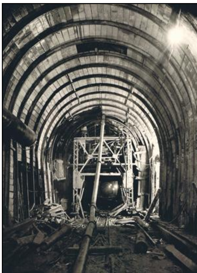
Ci-dessus et ci-dessous, la galerie avec ses coffrages et son échafaudage roulant
