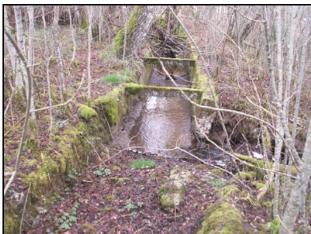
Drain en béton et ruisseau détourné vers la tranchée (à droite)
