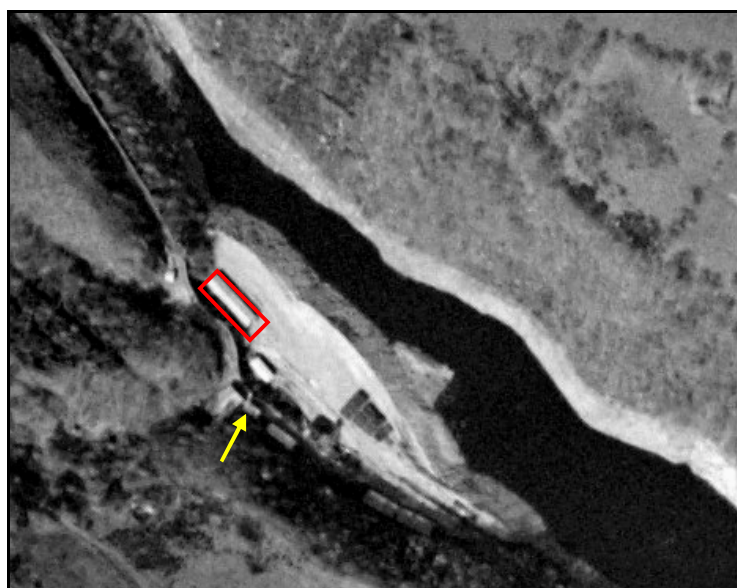
Vue aérienne du chantier de Vioux
