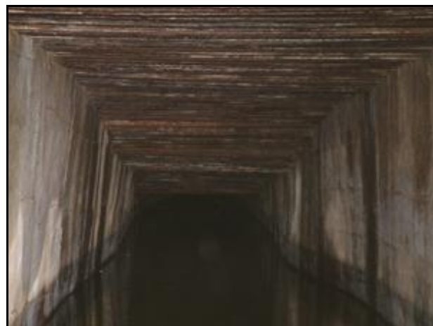
La fenêtre noyée et le plafond qui plonge dans l'eau, attestant de la forte pente en descente
