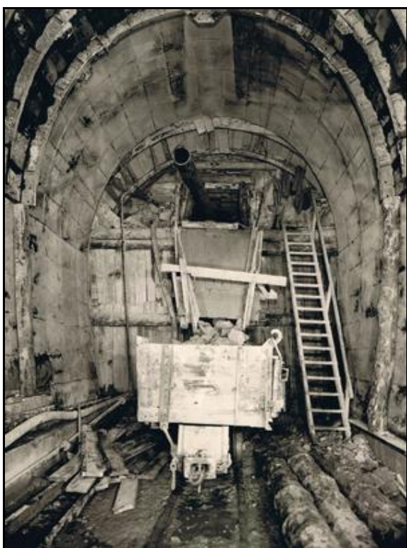
Trémie d'évacuation des déblais de la galerie pilote
