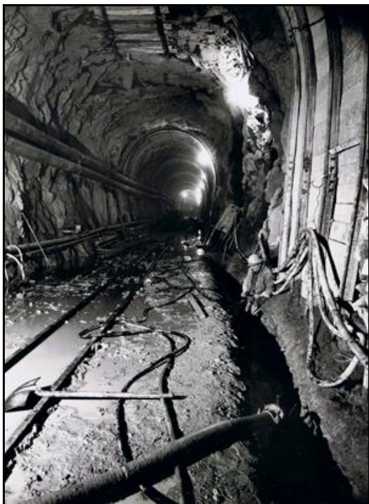
Ci-dessus et ci-dessous, la galerie avec ses coffrages et son échafaudage roulant
