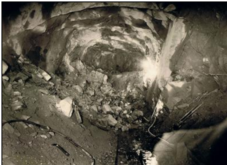
Ci-dessus et ci-dessous, deux belles photos du front de taille faisant apparaître la galerie pilote
