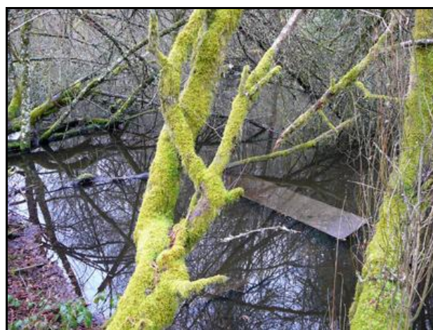
Mur nord émergant de l'eau
