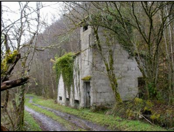
Le bâtiment solitaire du transformateur, aujourd'hui et...
