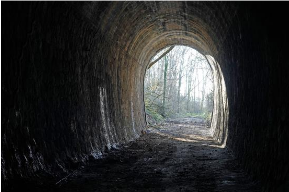
Intérieur du tunnel, vue vers l'entrée (29/01/2023)
