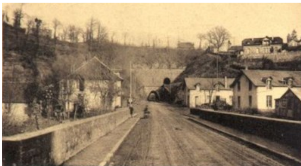
La sortie du tunnel du petit chemin de fer métrique au dessus du tunnel routier de la voie de grande communication qui deviendra plus tard la nationale 20 Paris > Espagne.
