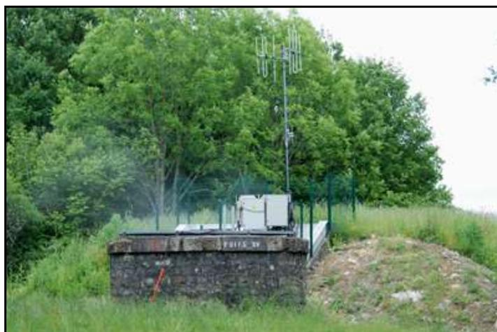
Le débouché du puits XV aujourd'hui, équipé d'équipements de télétransmission radio pour la sécurité
