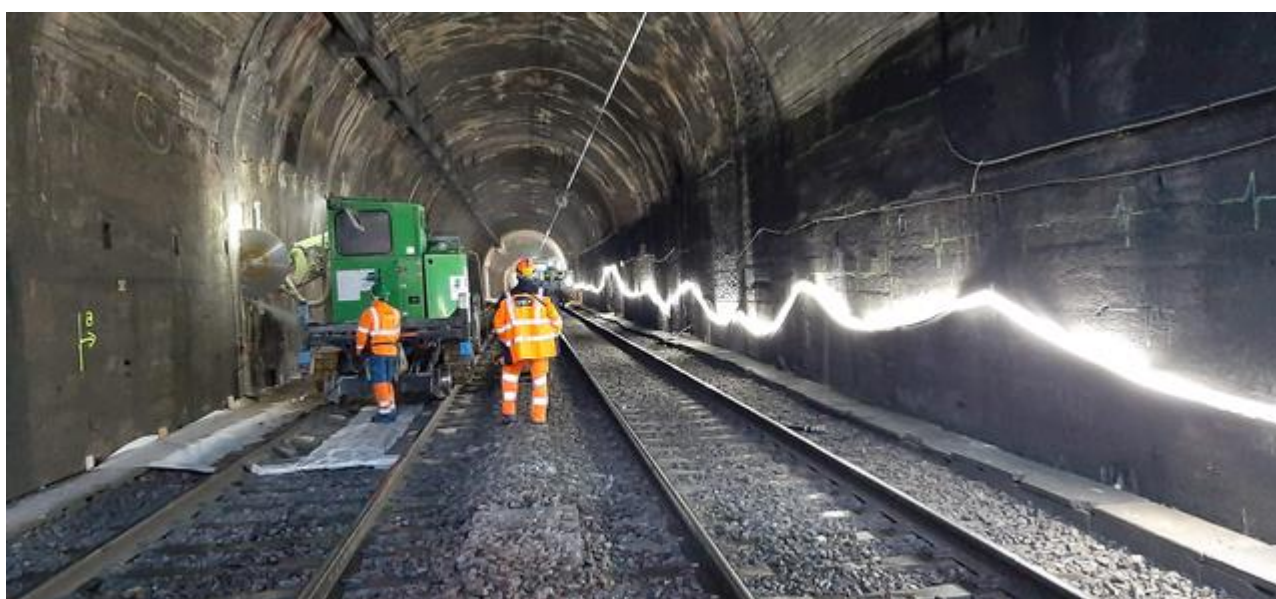
Ci-dessus, travaux de reprise des piédroits en 2020 (03/10/2020)
