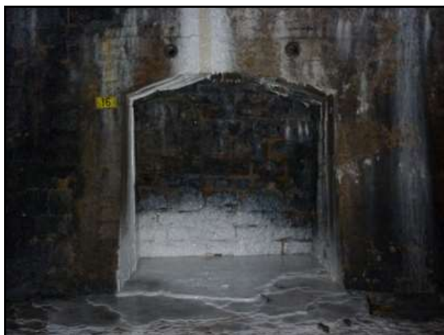
Deux niches du tunnel qui révèlent le mauvais vieillissement de celui-ci : infiltrations calcifiantes et dégradation des piédroits
