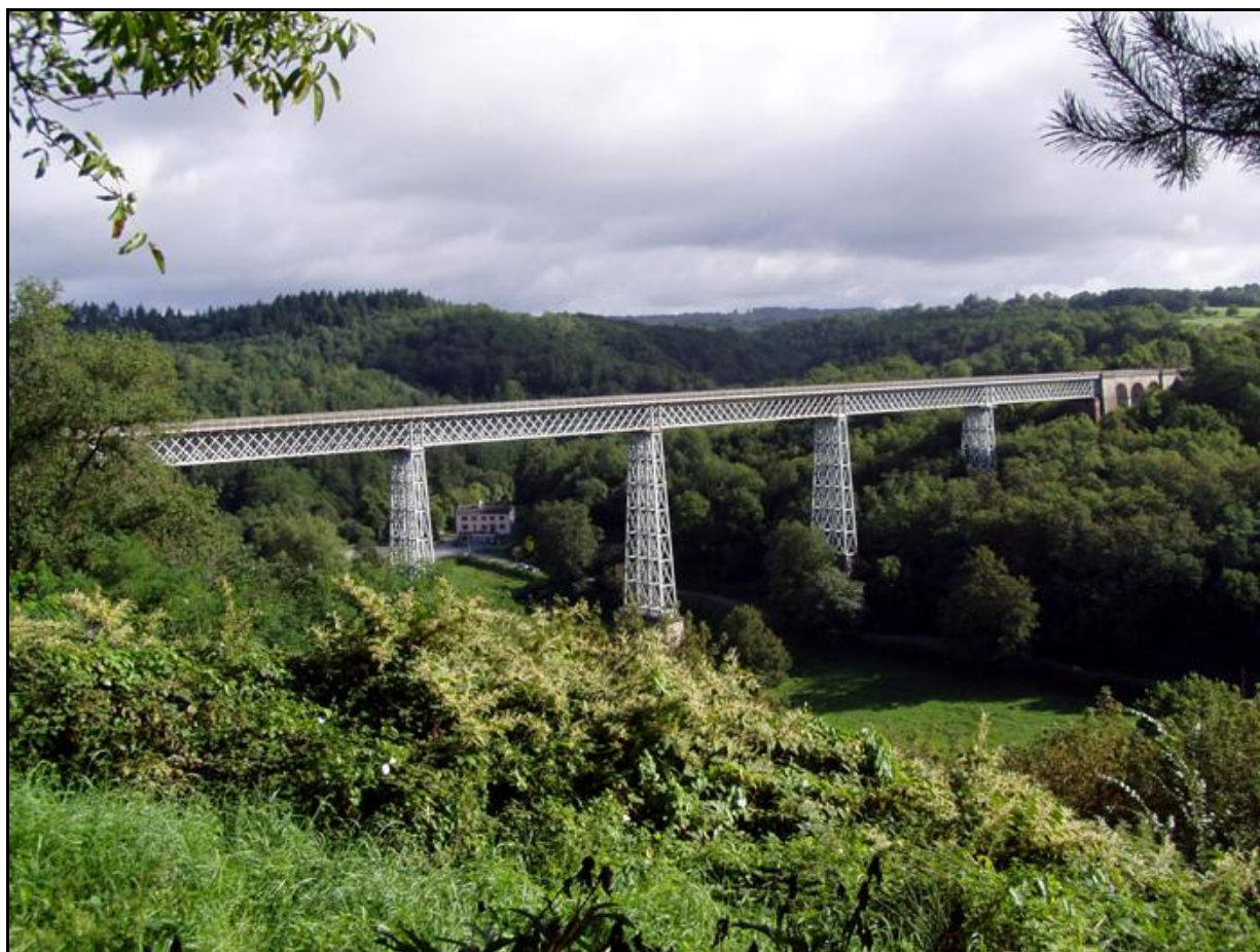
Le viaduc du Busseau sur Creuse
