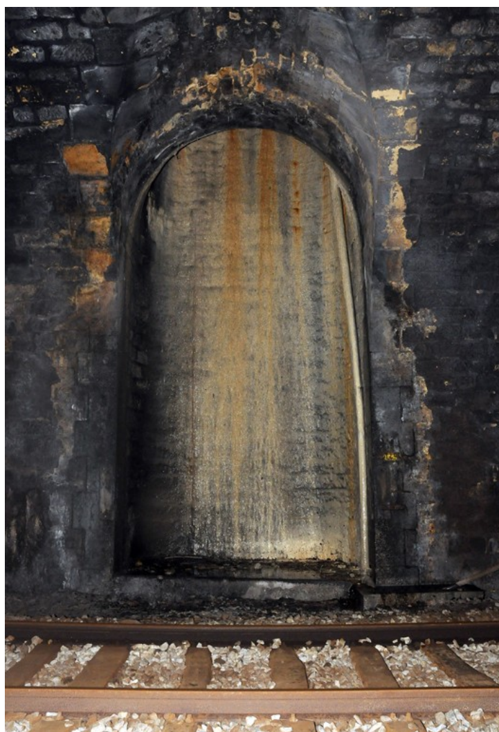
Base de la cheminée d'aération n°4 (2019)
