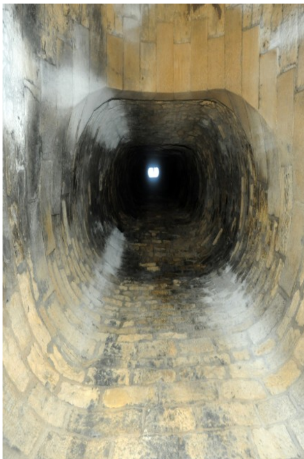
Cheminée d'aération n°2 (2019)
