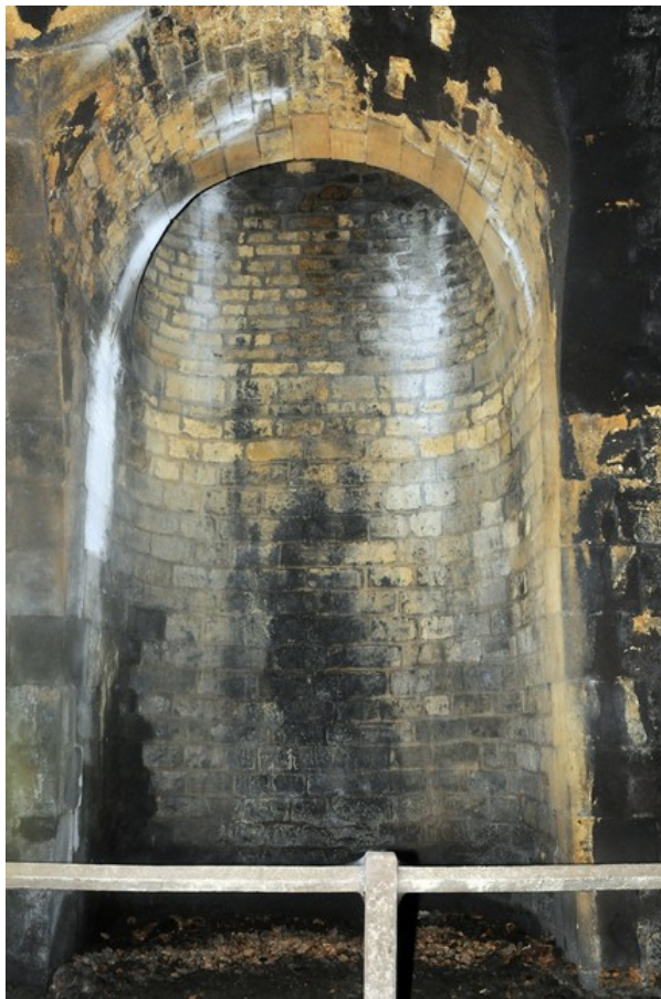
Base de la cheminée d'aération n°2 (2019)
