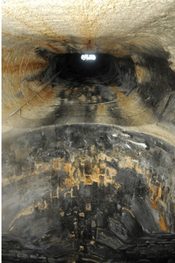
Cheminée d'aération n°4 (2019)
