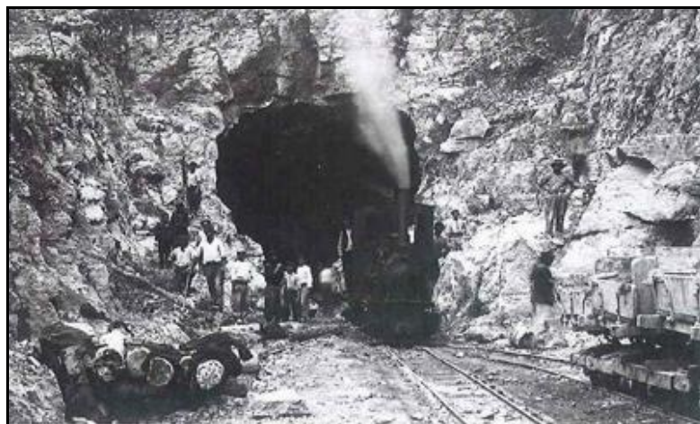
L'avancée des travaux côté suisse ; la galerie pilote a cédé la place à la galerie du tunnel proprement dit
