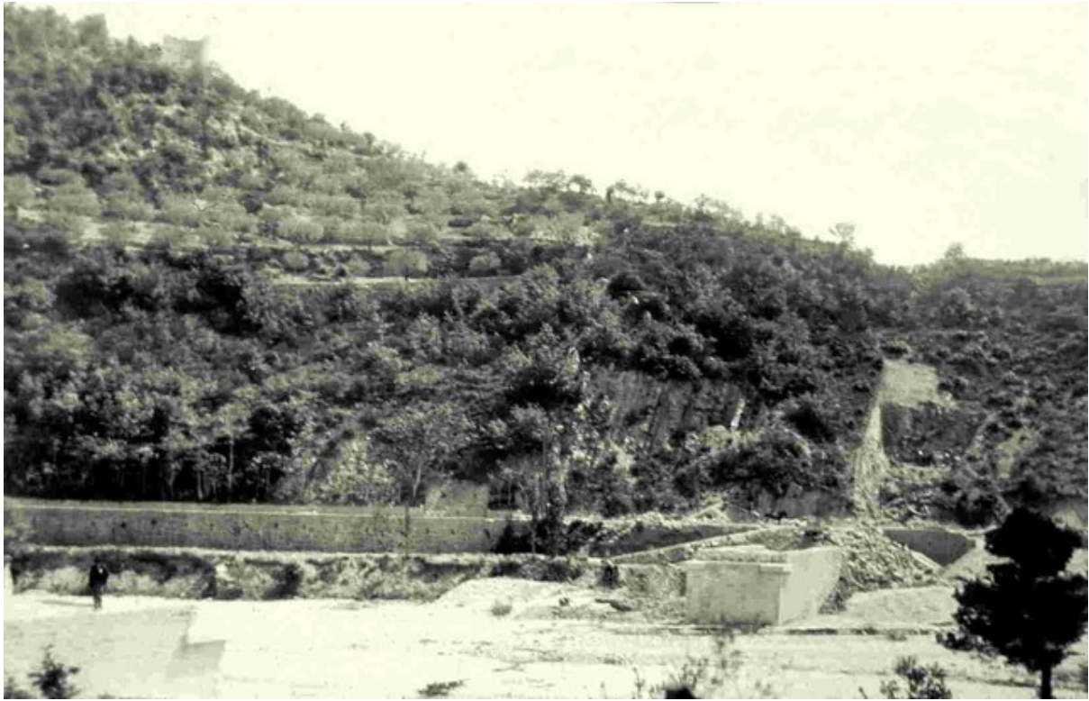
Début de construction de la culée Est du pont sur l'Ouvère qui précède le tunnel. A l'arrière-plan, la fouille d'entrée du tunnel en cours de déblaiement.
