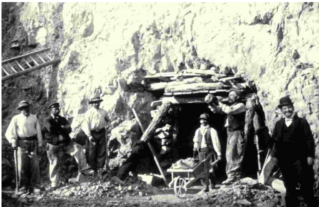
Les ouvriers devant l'entrée de la galerie de reconnaissance du tunnel
