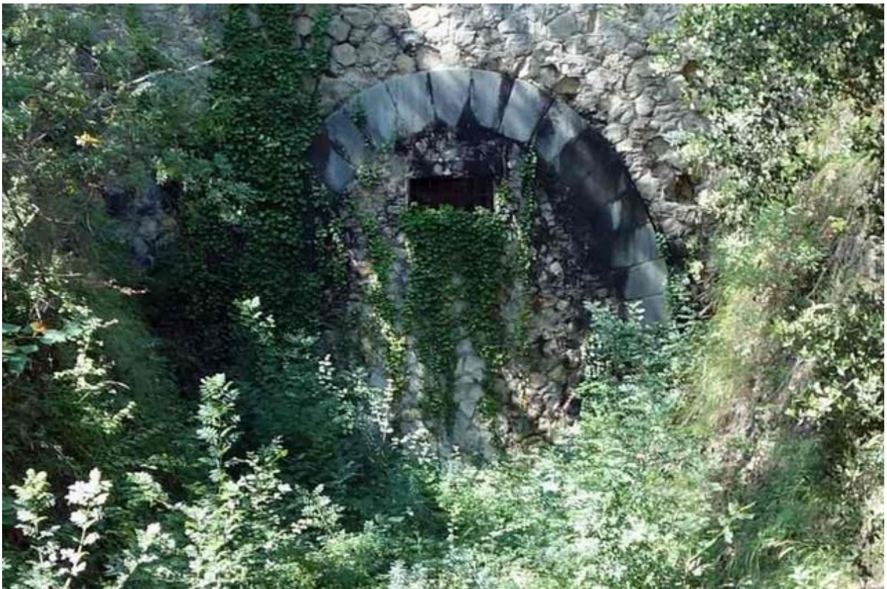
La sortie du tunnel murée, avant son réaménagement
