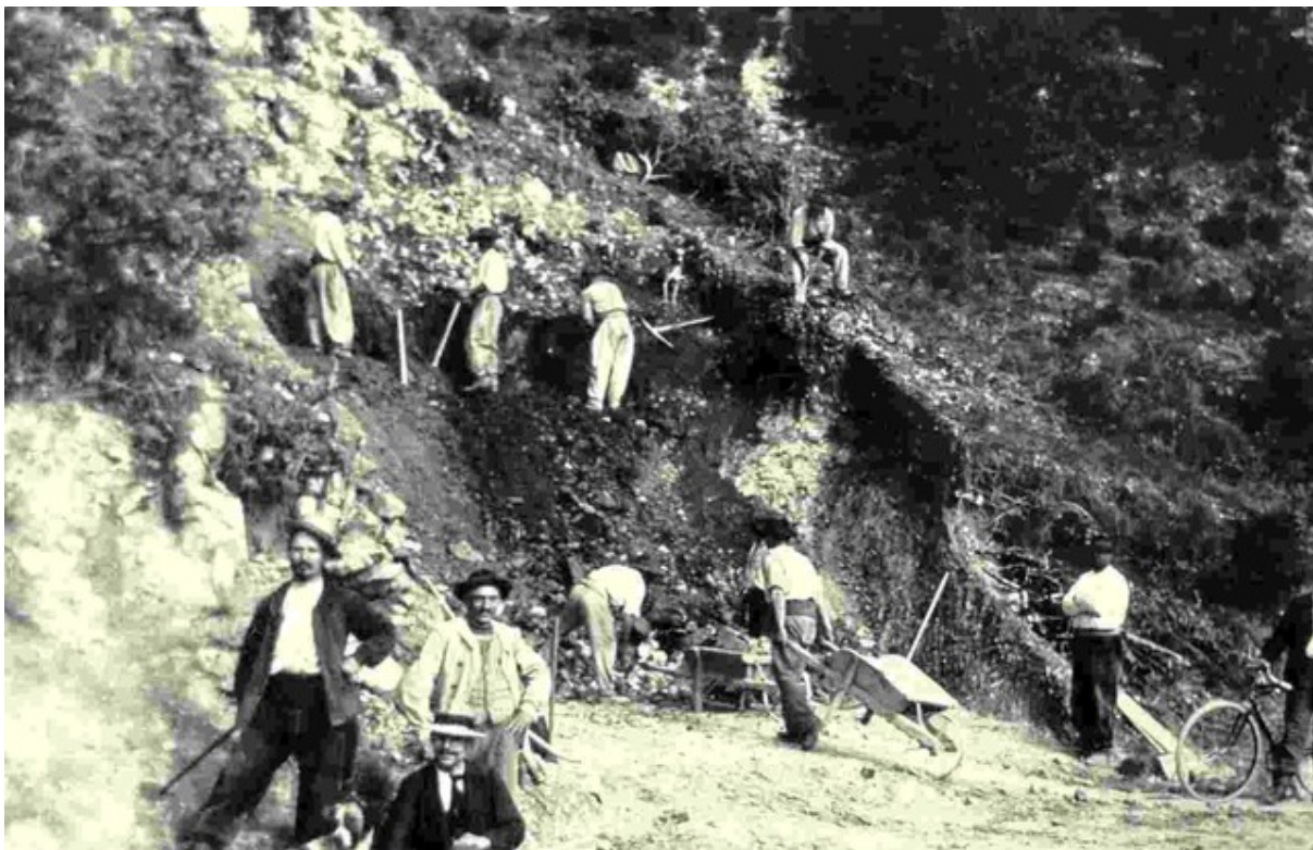
Début de la fouille d'entrée du tunnel.
