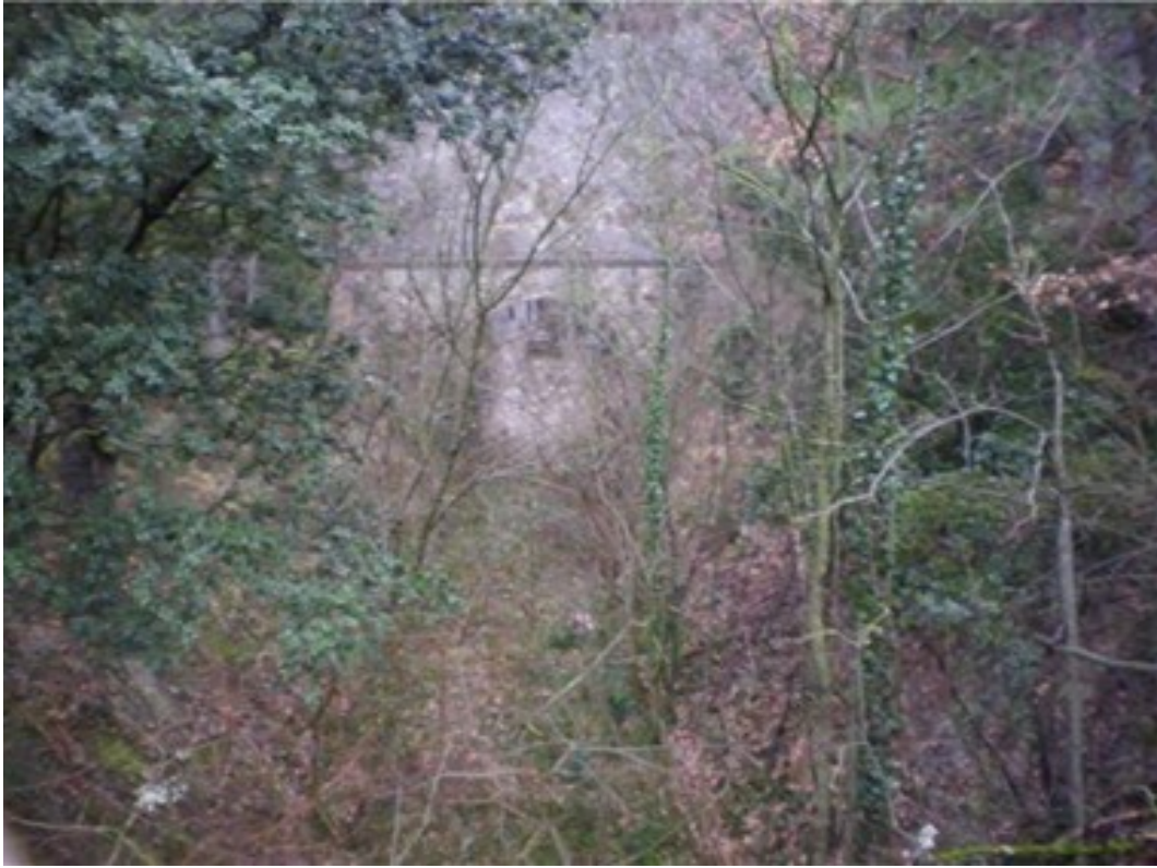
La sortie murée à peine visible derrière la végétation
