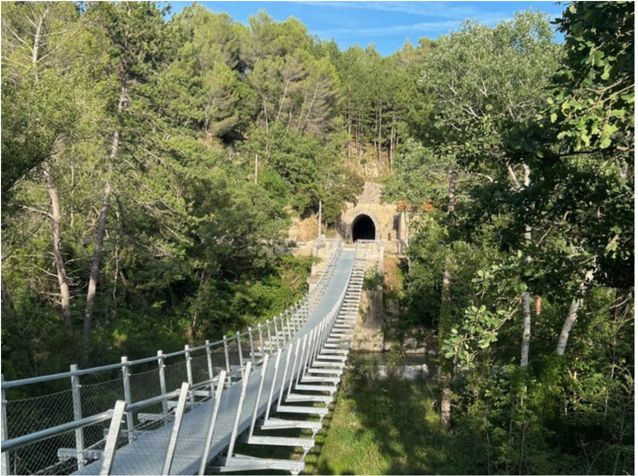
L'entrée du tunnel réaménagé avec la passerelle himalayenne qui le précède (2024)
