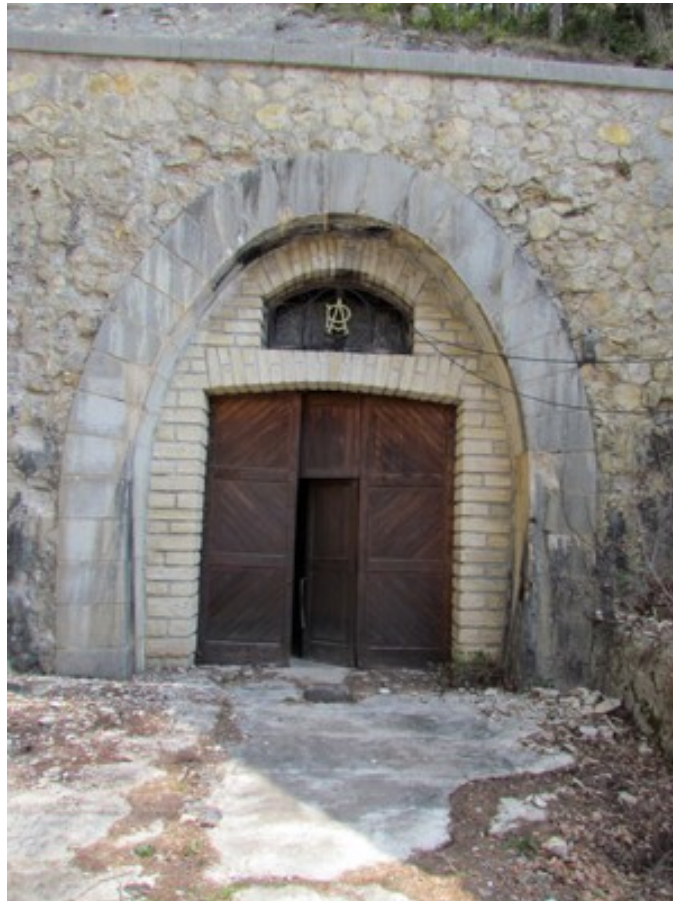
L'entrée du tunnel à l'abandon, avant son réaménagement
