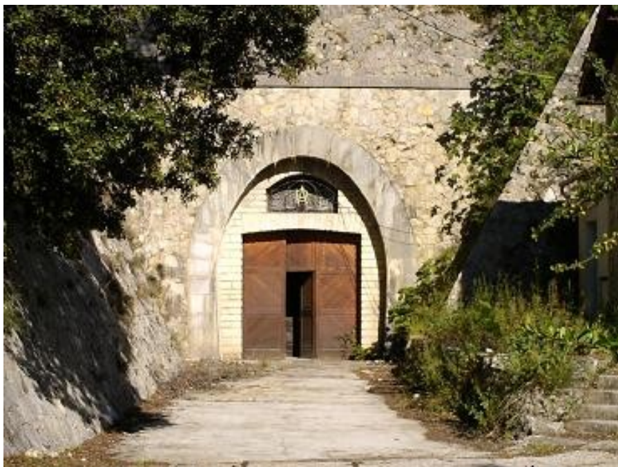
L'entrée du tunnel à l'abandon, avant son réaménagement
