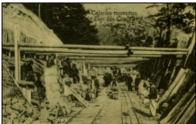
La construction du tunnel d'Anduze : A gauche, la préparation de la tranchée couverte des Cordeliers A droite, l'amorce du tunnel proprement dit
