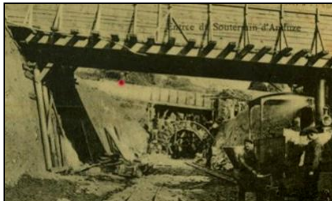
La construction du tunnel d'Anduze : A gauche, la préparation de la tranchée couverte des Cordeliers A droite, l'amorce du tunnel proprement dit
