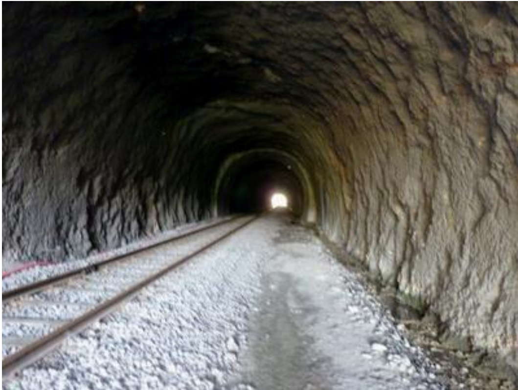
La belle galerie du tunnel de Saint Ambroix
