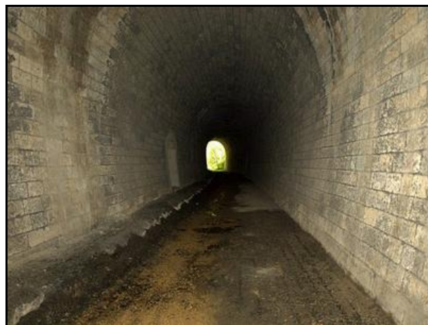
La galerie et son drain d'évacuation d'eau latéral
