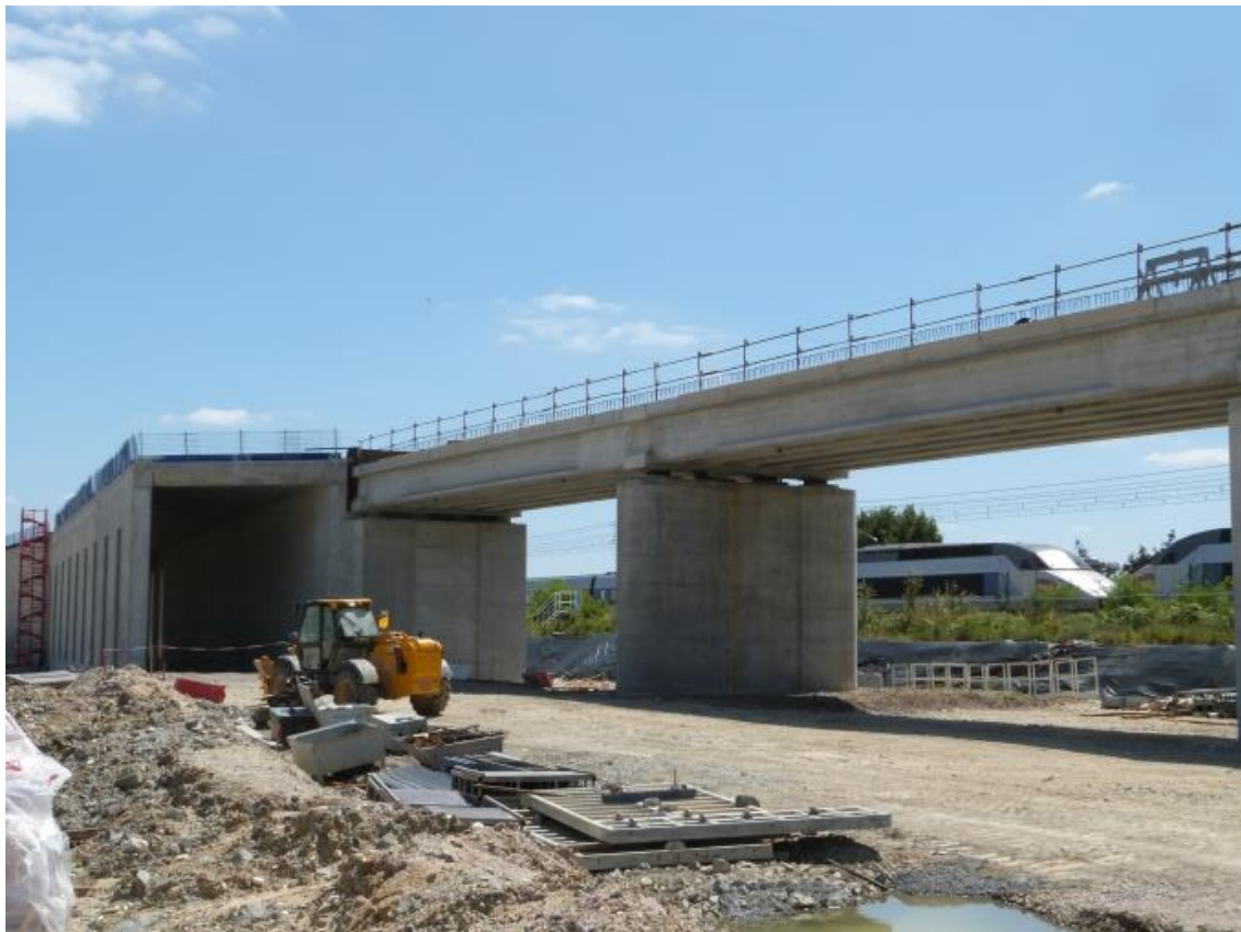
L'entrée lors de la construction
