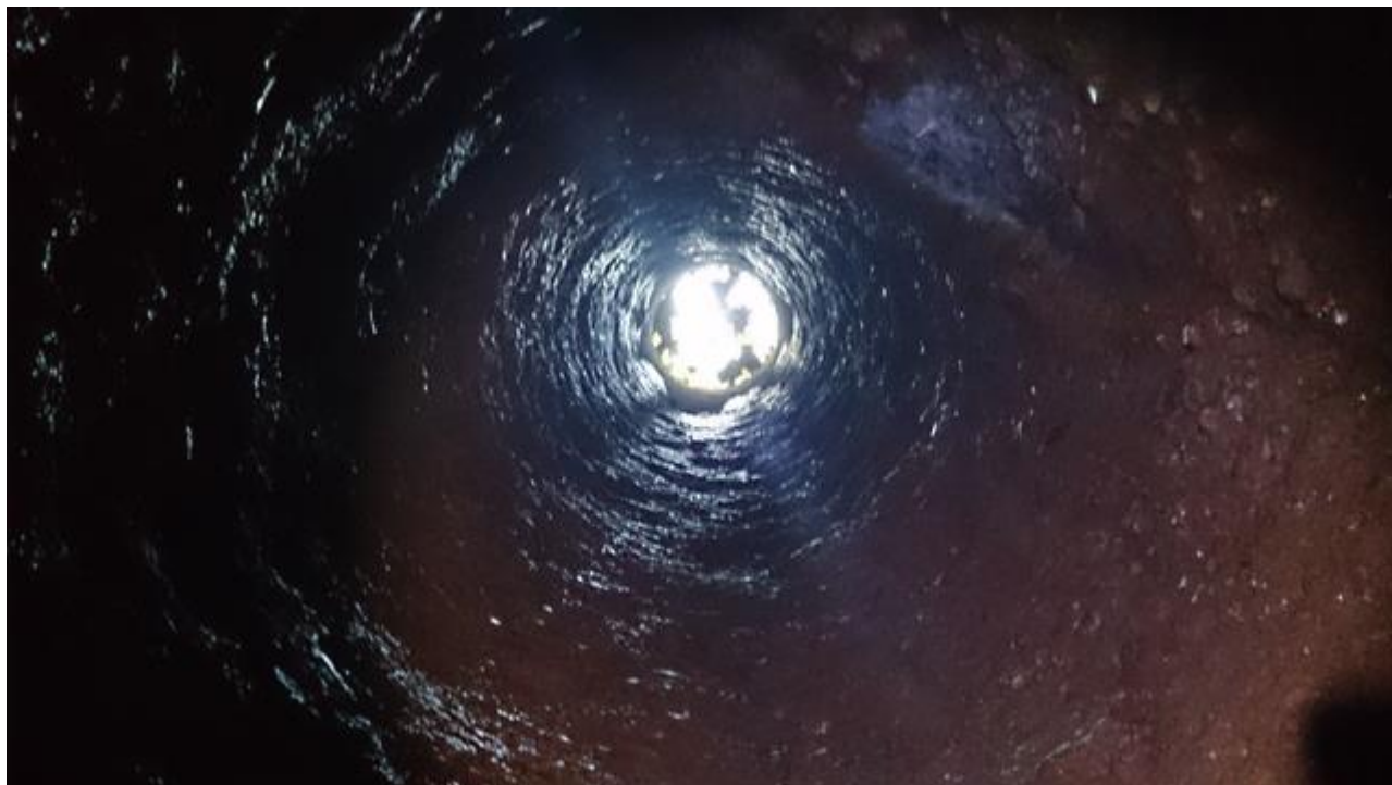
L'une des cheminées d'aération
