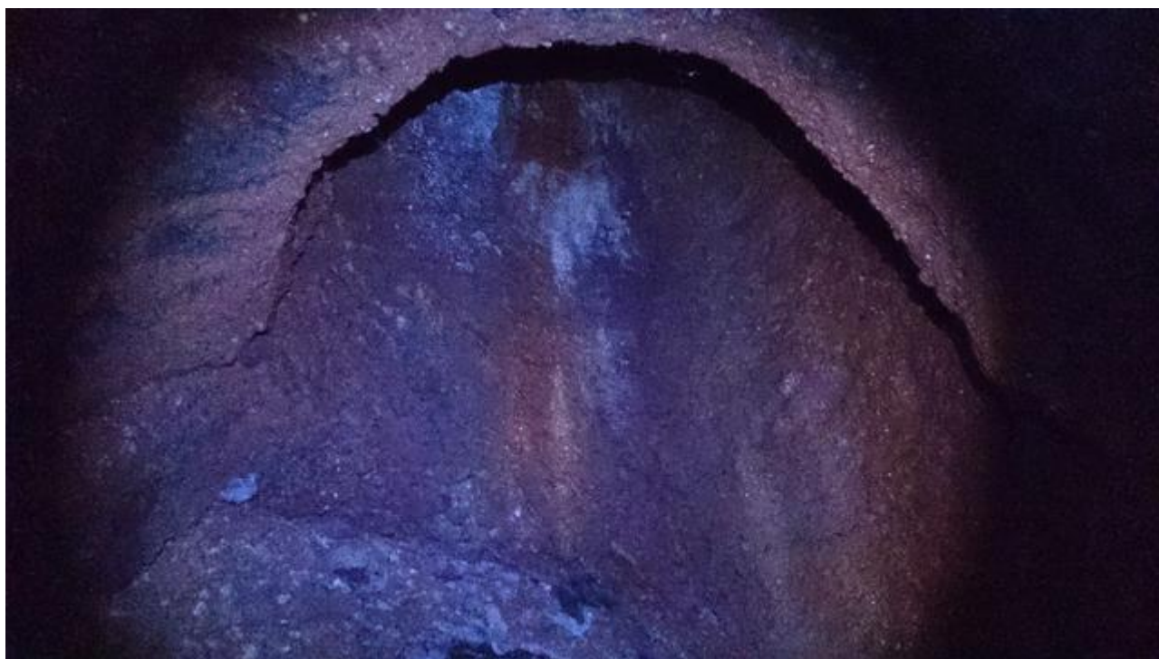
L'une des cheminées d'aération
