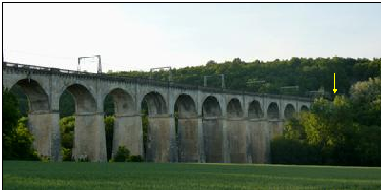
Le joli viaduc de Chasseneuil qui fait suite à la sortie du tunnel qui se trouve sous la flèche
