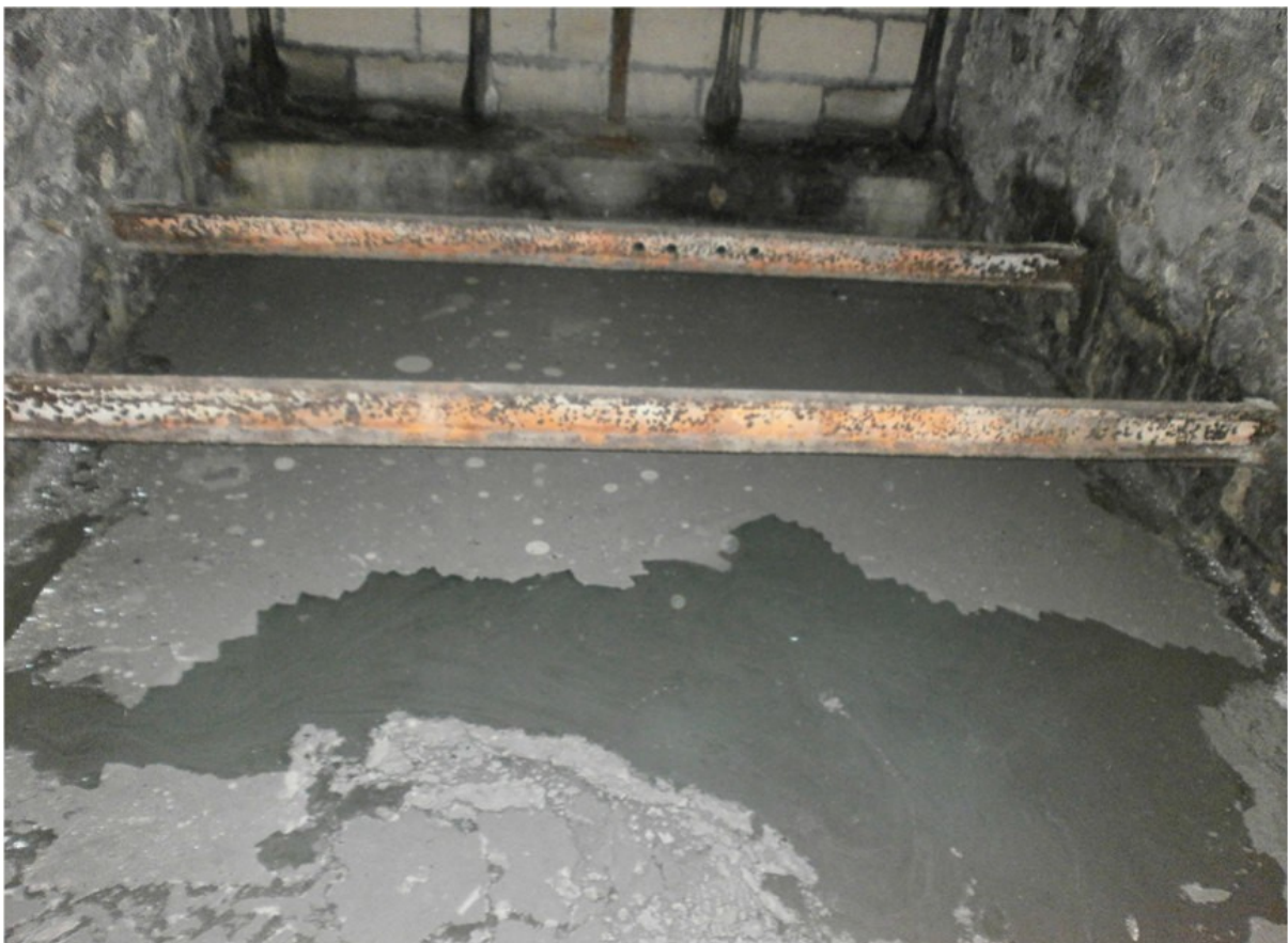
Vue du réservoir au niveau du puits n°4
