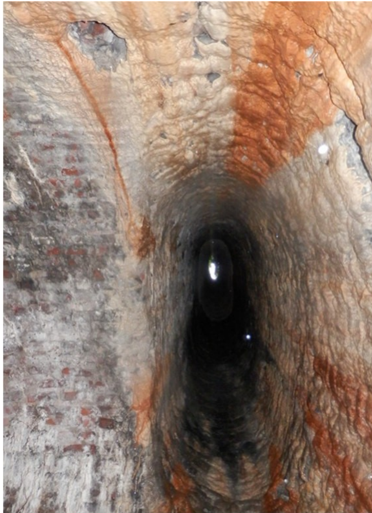
Vue de l'une des cheminées d'aération depuis le tunnel
