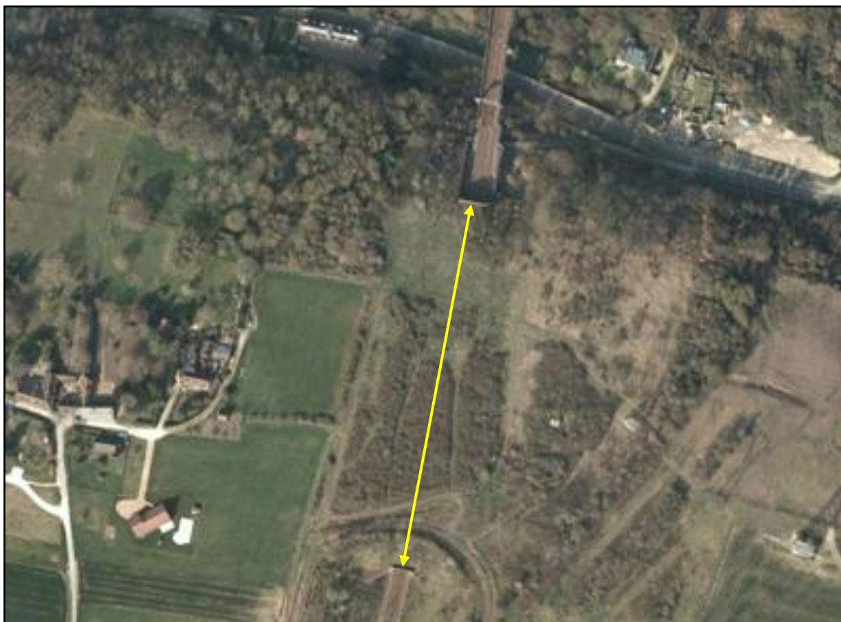
Vue aérienne de la tranchée couverte
