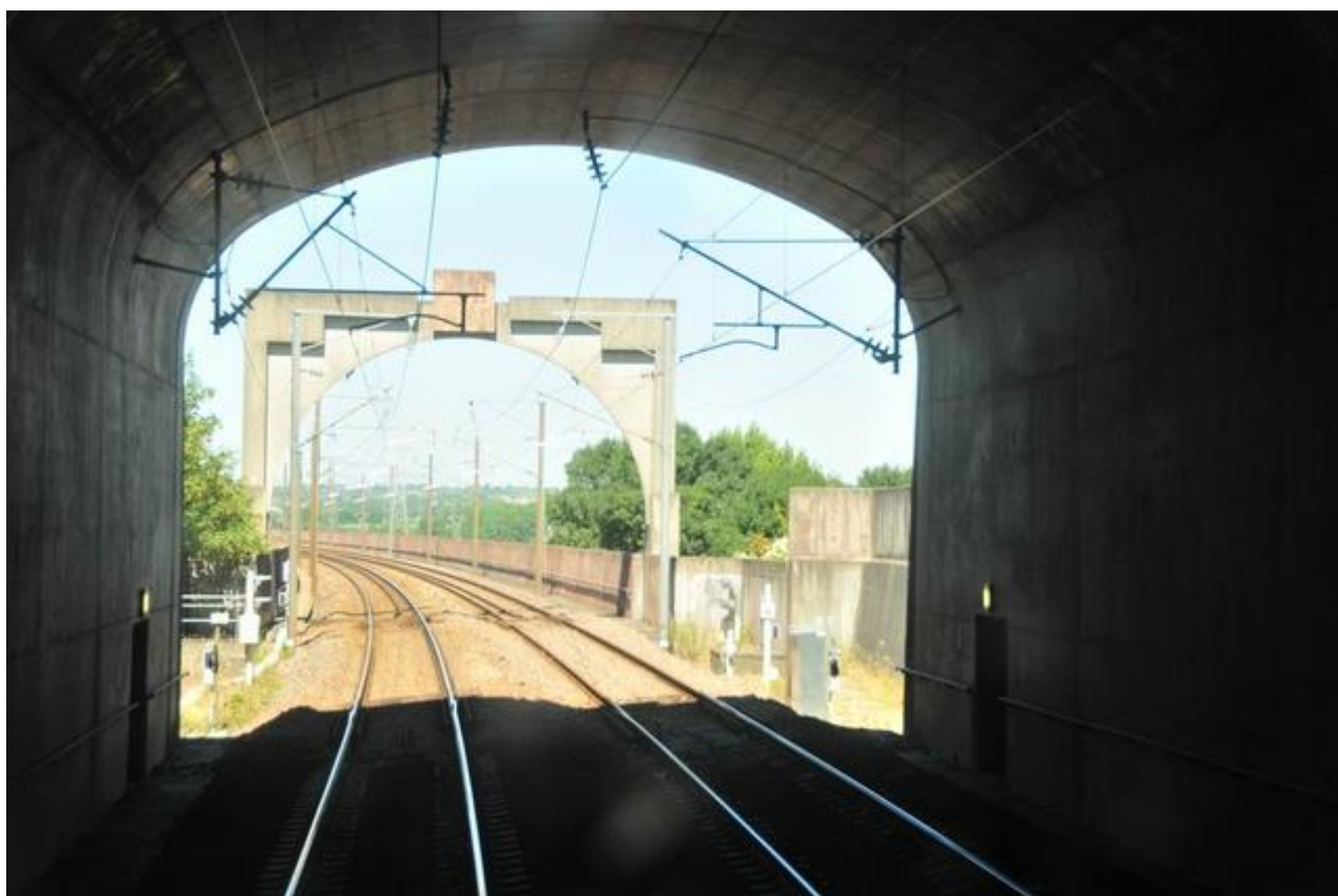
L'entrée vue de l'intérieur de la galerie
