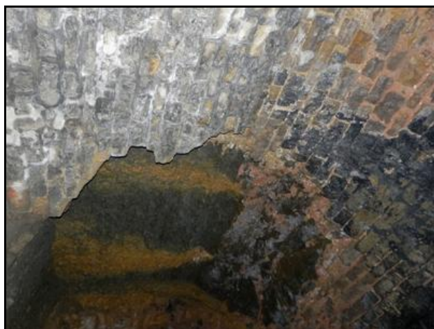
Décrochements de voûte et piédroits effondrés
