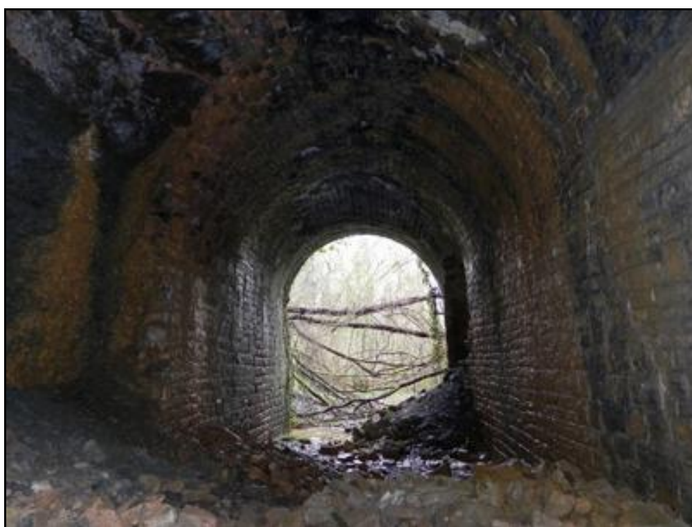
Décrochements de voûte et piédroits effondrés
