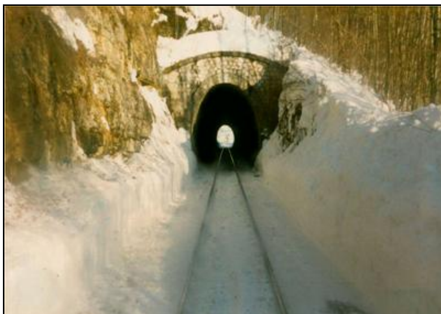
La sortie du tunnel des Bataillards sous la neige
