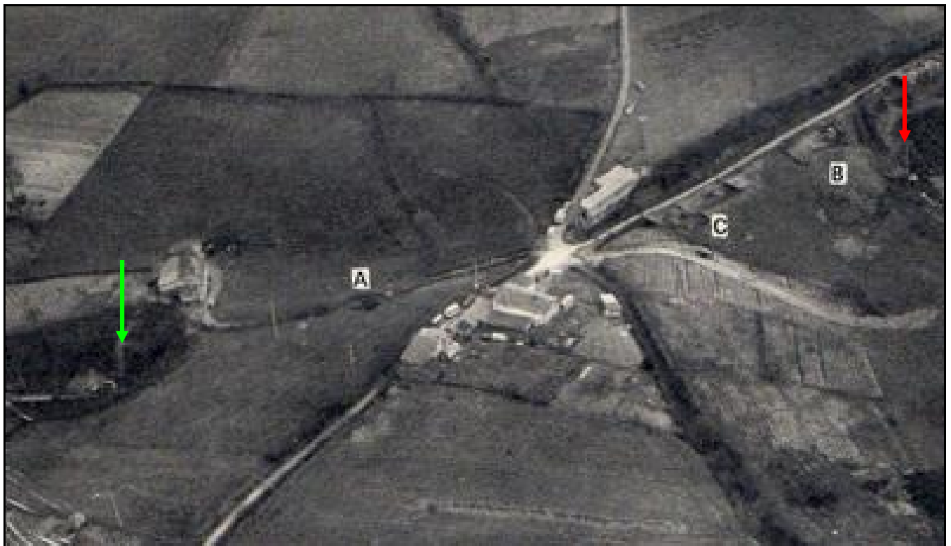
Vue générale des dessus du tunnel avec l'entrée nord (flèche verte), les trois fontis d'effondrement (A, B et C) et la sortie sud (flèche rouge)
