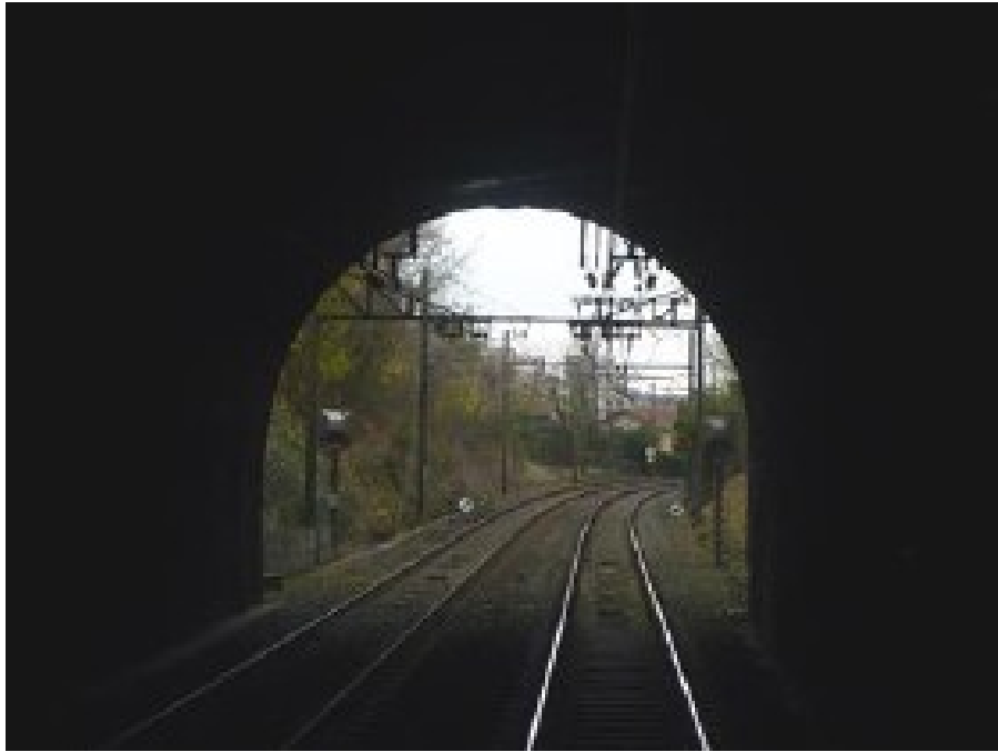
La sortie vue de l'intérieur.
