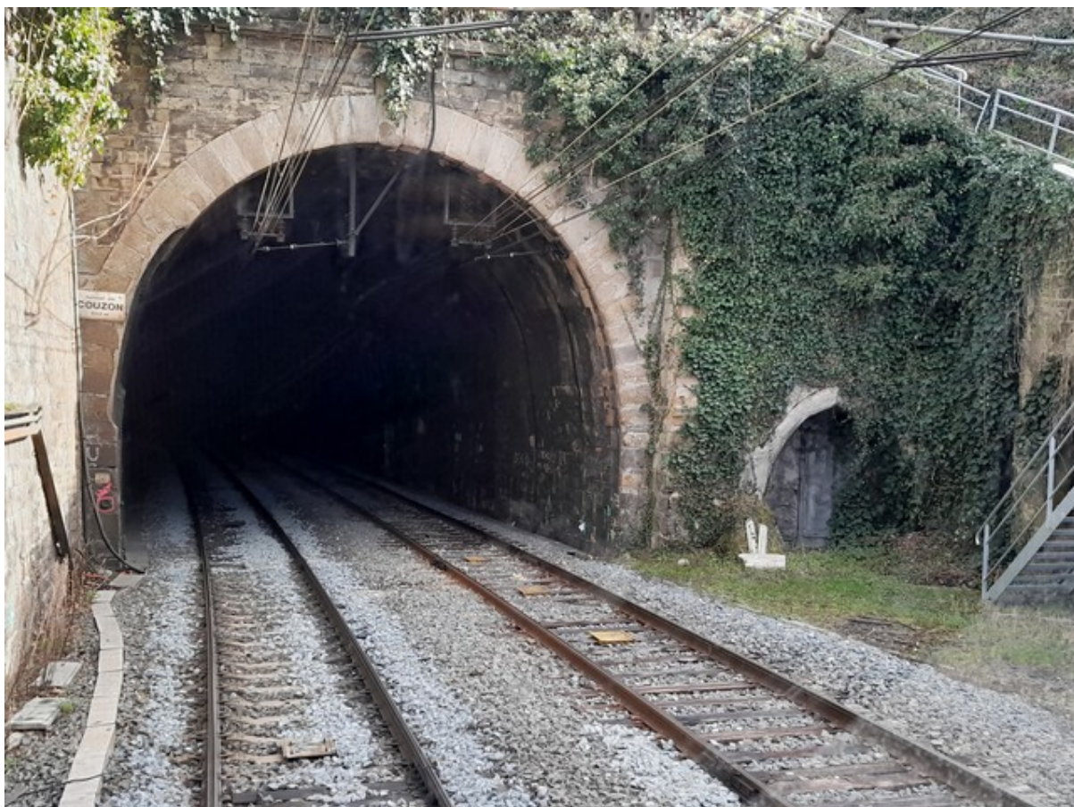
L'ancien tunnel (à droite) et le nouveau tunnel (à gauche) – 18 février 2024
