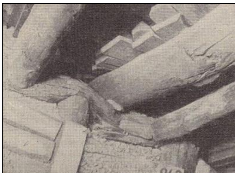
Ecrasement et rupture des boisages des travaux
