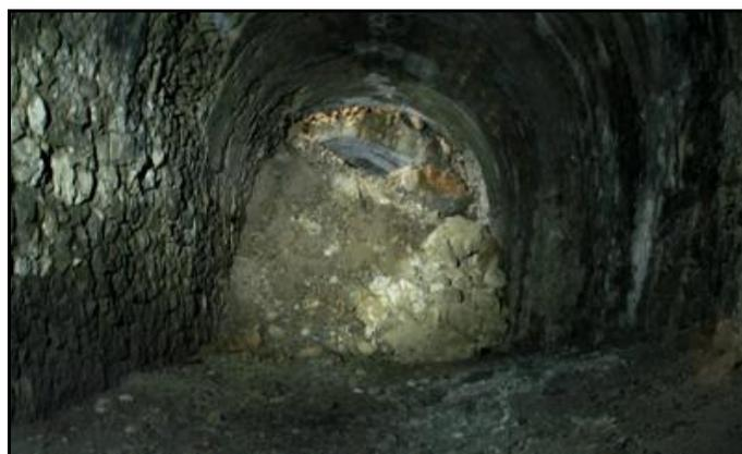
L'effondrement vu côté entrée et côté sortie
