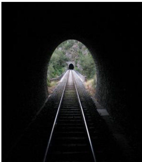
L'entrée du tunnel de Poutès avec, dans le fond, la sortie du tunnel des Chastées
