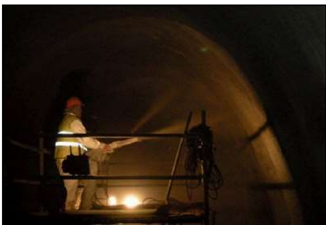
Projection du béton
