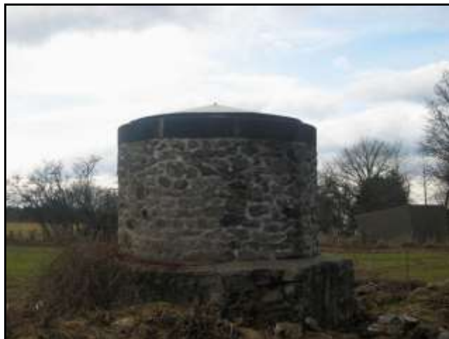
Le débouché de la cheminée, en surface
