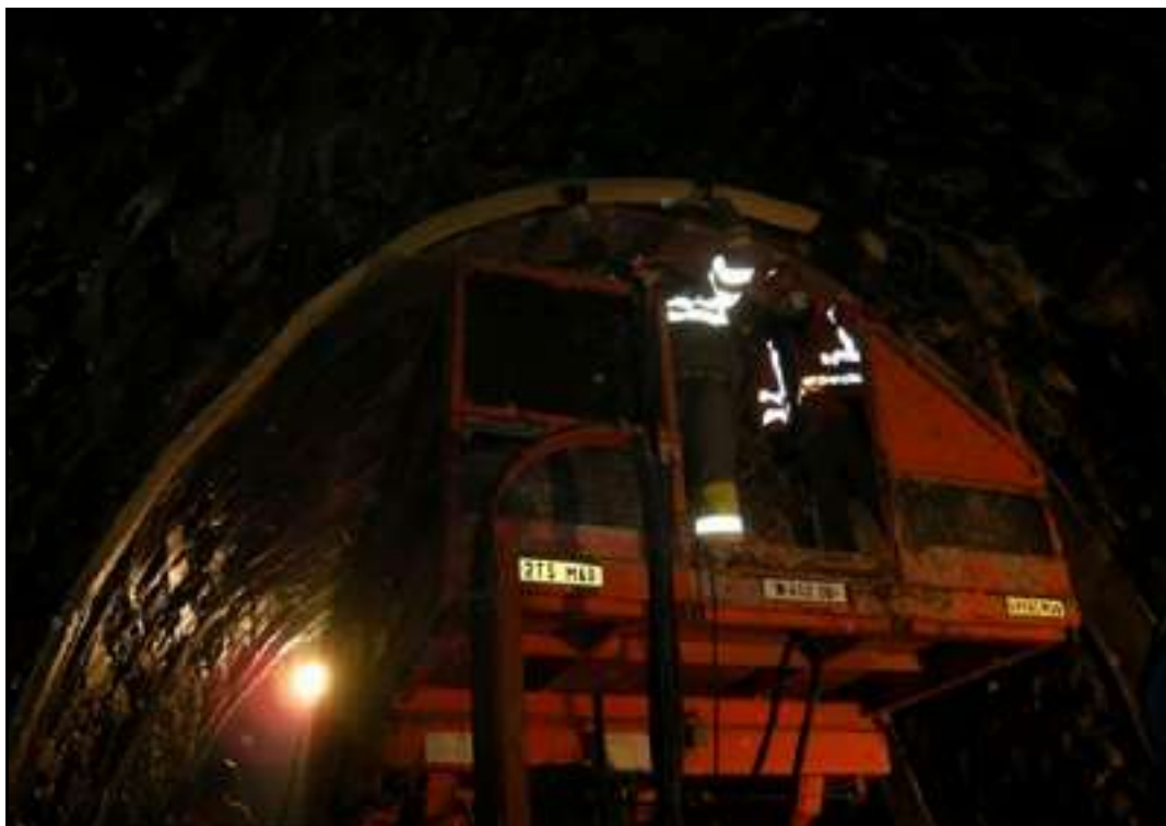
Préparation de la voûte à l'aide de la nacelle télescopique
