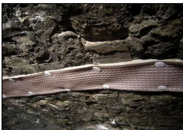
Forages latéraux dans les parois et pose de bandes drainantes
