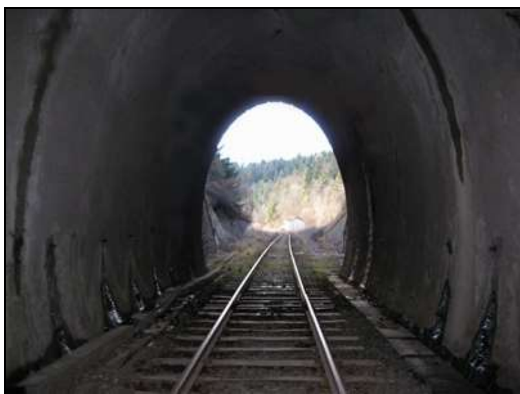
Ci-contre, l'entrée du tunnel vue de l'intérieur avec, au fond, l'ancienne gare de Fix Saint Geneys
