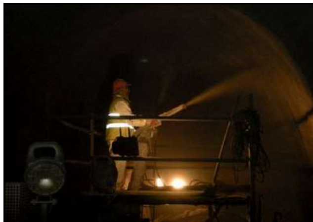
Projection du béton
