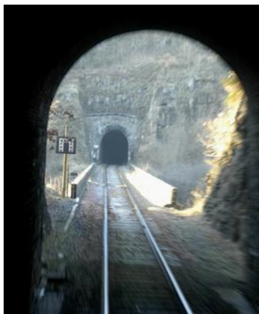
L'entrée du tunnel de Chambezon vue depuis la sortie du tunnel de Planzol
