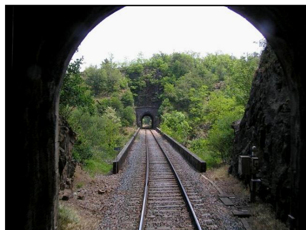
La sortie du tunnel de Planzol vue depuis l'entrée du tunnel de Chambezon
