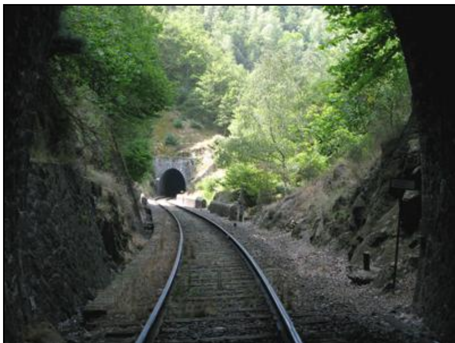
Ci-dessous, la sortie du tunnel de Jacquet vue depuis l'entrée du tunnel de Douchanez
